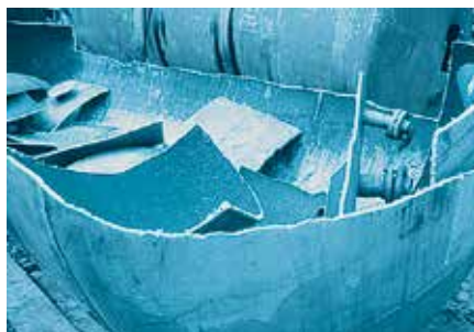
Рис. 6. Ручная плазменная резка алюминиевой железнодорожной цистерны: начало и окончание резки.
